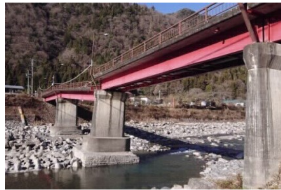
現在の中橋は基礎を洗掘され傾いている中央の橋脚と落ちた桁
